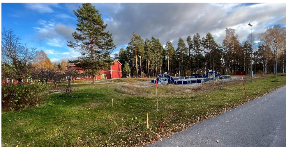
Jädraås skola sedd från Erskines väg. I bilden ses gymnastikhallen som en högre byggnadsvolym samt skolans friytor med bland annat en belyst multiplan.
