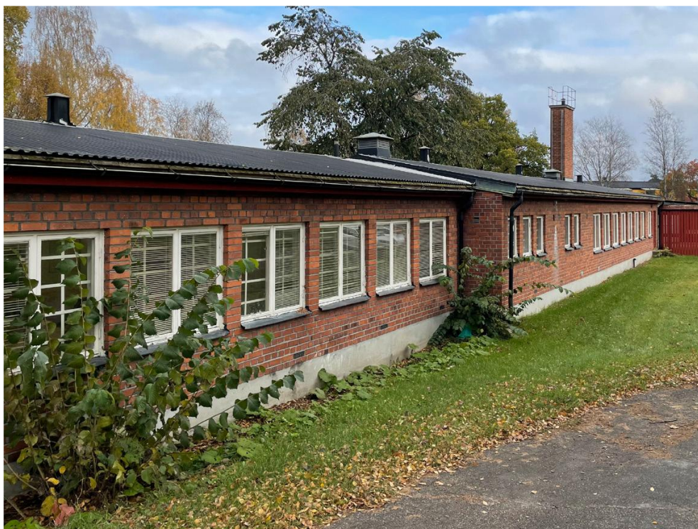
Paviljongbyggnader inom planområdet. Foto Kulturmiljöutredning Tyréns 2024
