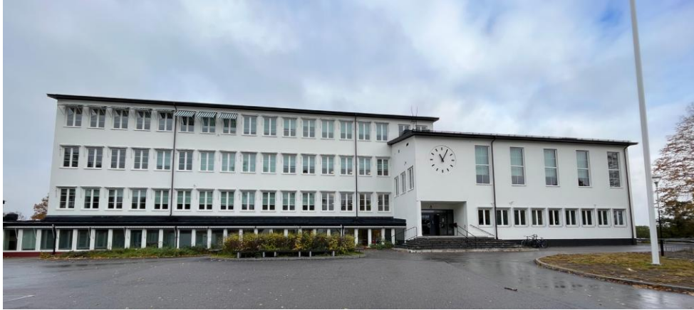
Tidigare Samrealskolan med tillbyggnad. Foto Kulturmiljöutredning Tyréns 2024
