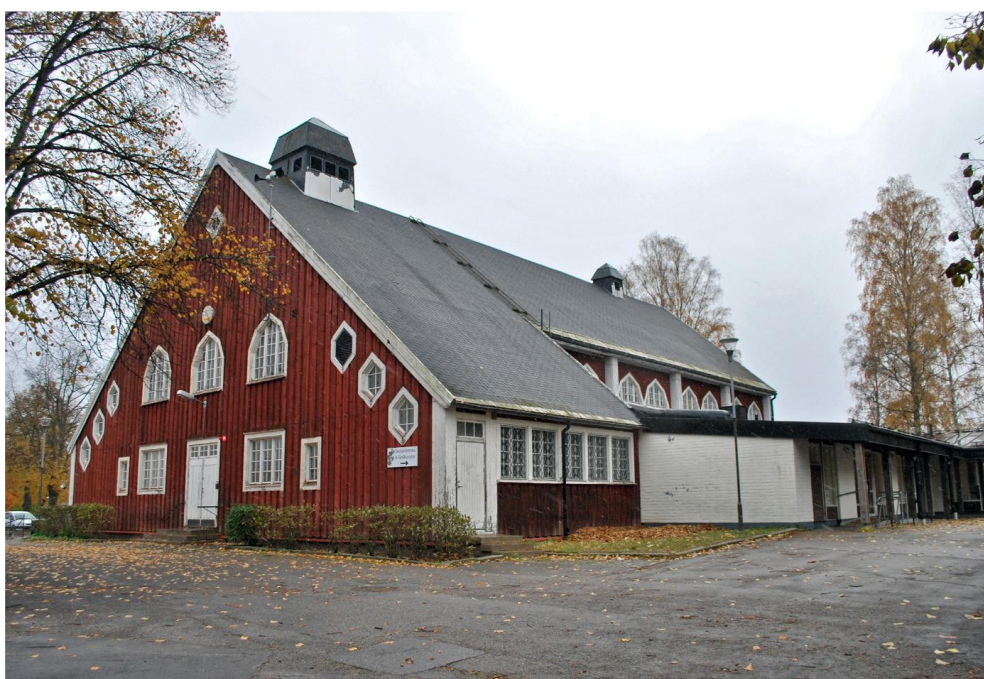
Äldre gymnastiksal. Foto kulturmiljöutredning Tyrens
