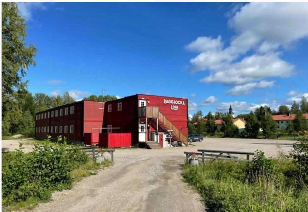
Foto som visar befintlig bebyggelse med tidsbegränsat bygglov på fastighet Prästbordet 1:108.
