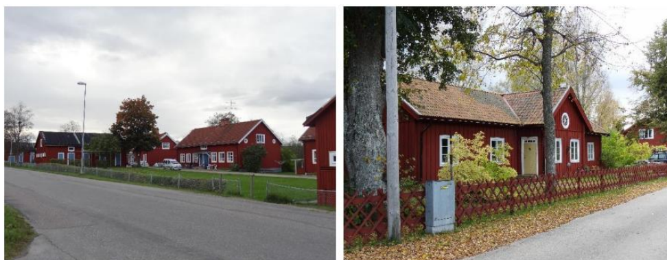
Bilder som visar bebyggelsen längs med bruksgatorna Vigatan (vänster) och Wijberget (höger). Källa: Länsstyrelsen
