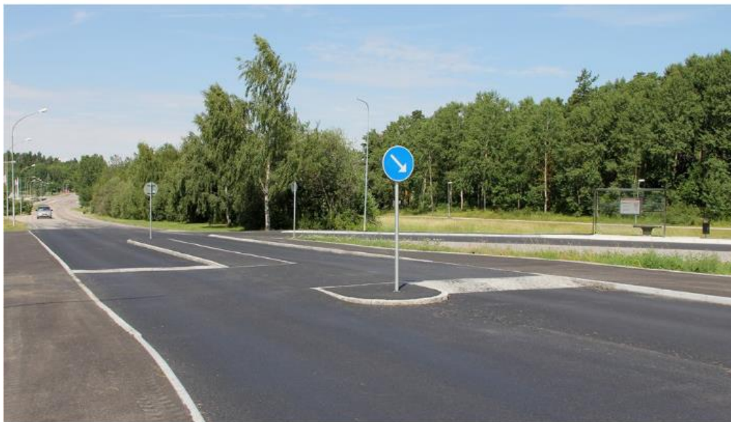
Figur 3-8. Platågupp kombinerat med passage, utformas med betongramp i tillfart och utspetsad nedfart. Foto Göran Jonsson, Eskilstuna kommun. Källa: Trafikförvaltning, region Stockholm, 2020. Riktlinjer Utformning av infrastruktur med hänsyn till busstrafik.
