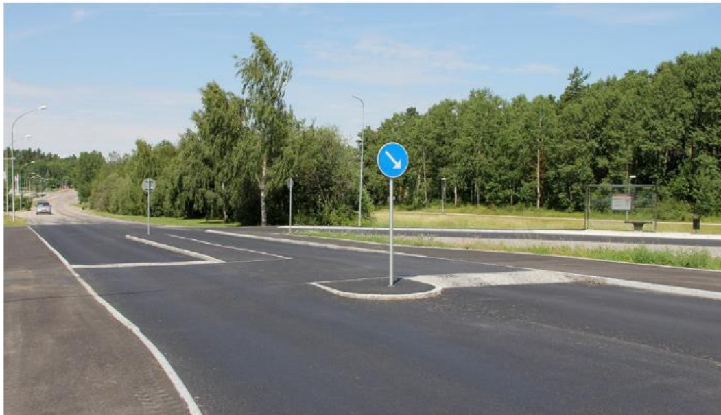
Figur 3-9. Platågupp kombinerat med passage, utformas med betongramp i tillfart och utspetsad nedfart. Foto Göran Jonsson, Eskilstuna kommun. (källa: Trafikförvaltning, region Stockholm, 2020. Riktlinjer Utformning av infrastruktur med hänsyn till busstrafik).
