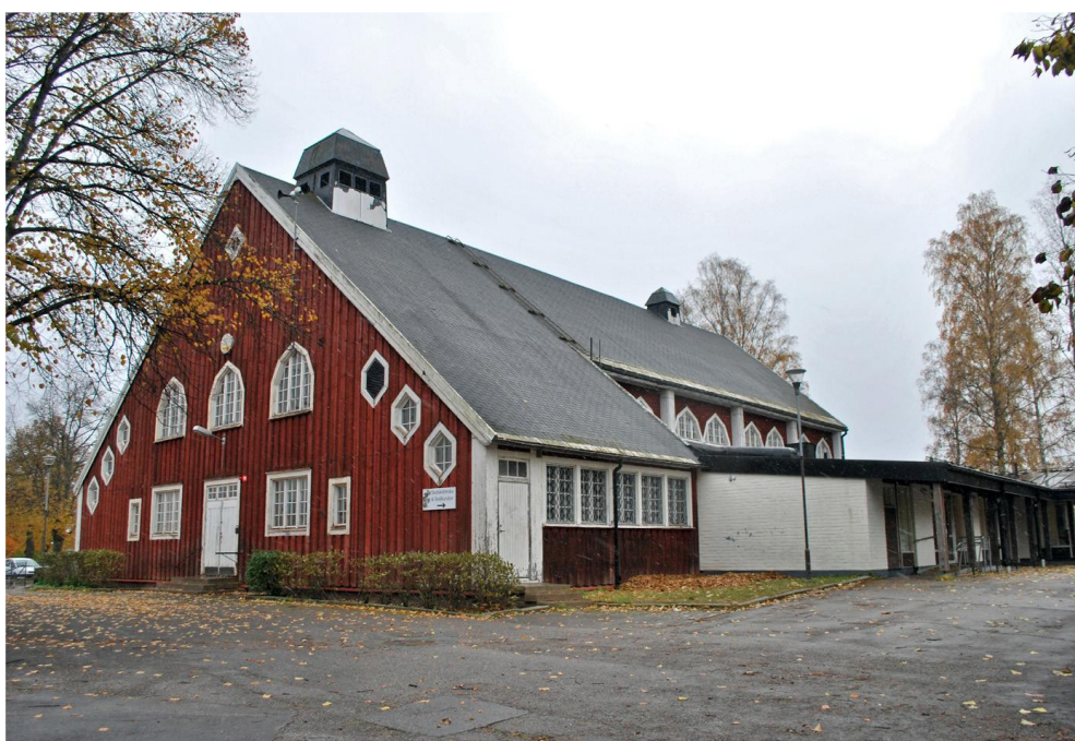
Äldre gymnastiksal. Foto kulturmiljöutredning Tyrens
