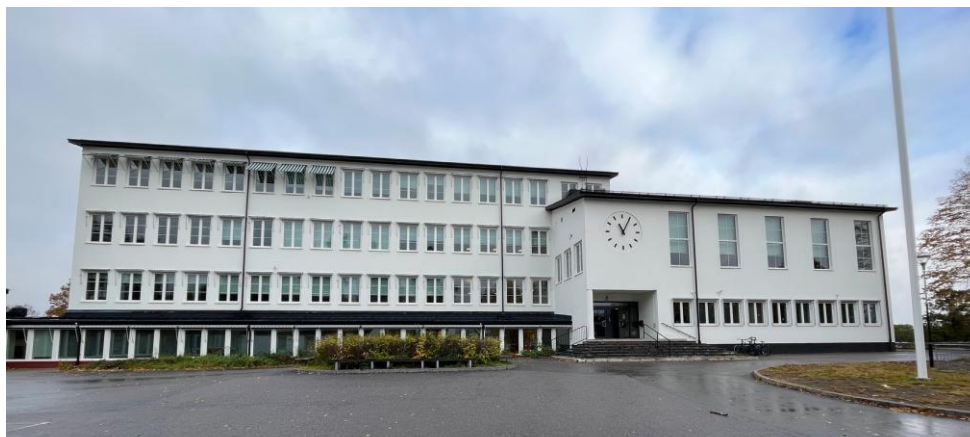
Tidigare Samrealskolan med tillbyggnad. Foto Kulturmiljöutredning Tyréns 2024
