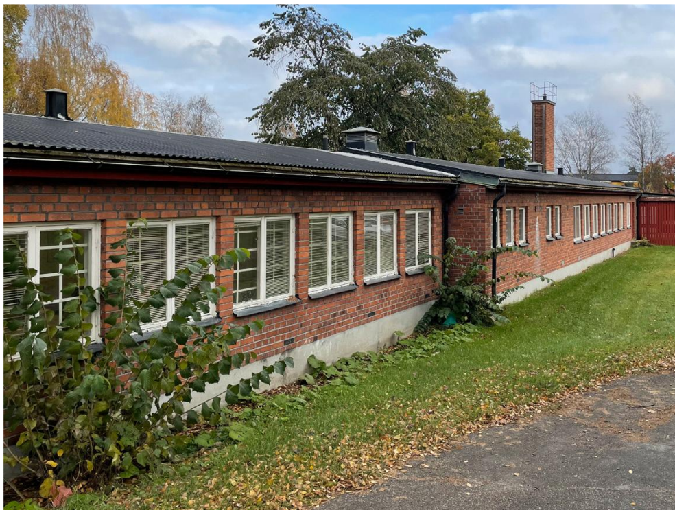
Paviljongbyggnader inom planområdet. Foto Kulturmiljöutredning Tyréns 2024
