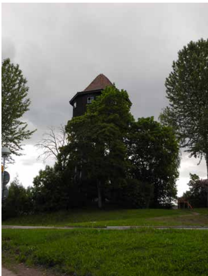
Det nedlagda vattentornet vid Näsby sjöns rastplats är ett av Storviks mest kända landmärken.
